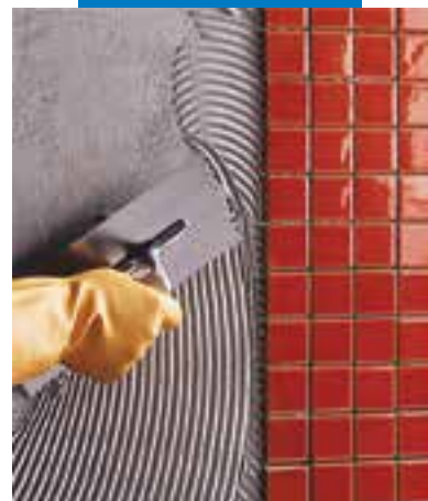
Colocación de cerámicos
