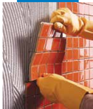
Colocación de cerámicos
