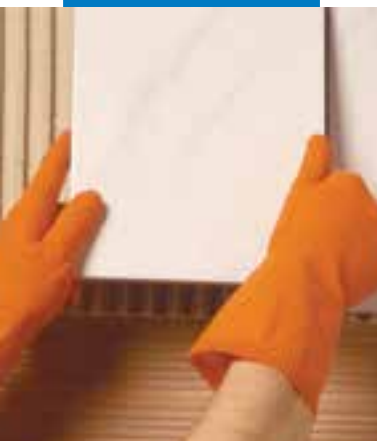
Colocación en pared de revestimiento cerámico
