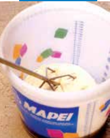
Mezcla de Mapeset con agitador mecánico
