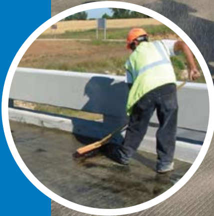
Esparcido de arena de Planiseal LVB luego de la aplicación
